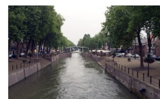
AANLEGGEN IN VREESWIJK AAN DE LEK
