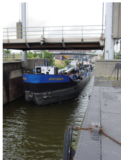
Passage Gorinchemse kanaalsluis
