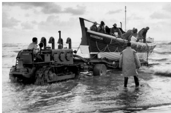
Motorstrandreddingboten, onzinkbaar, maar niet zelfrichtend, overnaads teakhouten romp. 1922 (type Eierland, lengte 10,30 m. 13 stuks) Operationele gebruiksduur van dit type reddingboot: 71 jaar .
